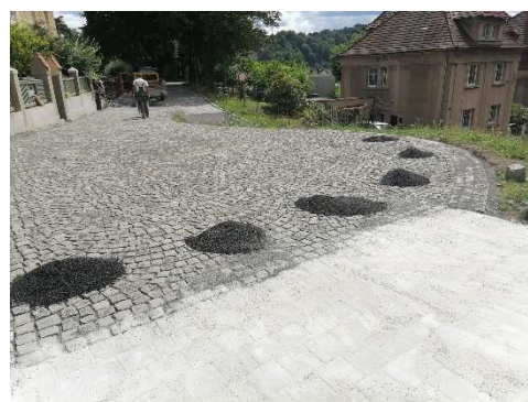
Oprava chodníku u školy a Komenského
