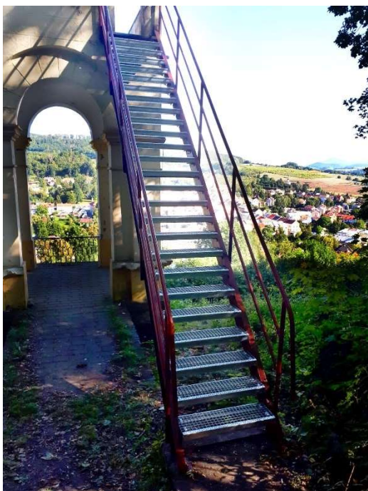
Oprava schodů – Ploučnická vyhlídka
