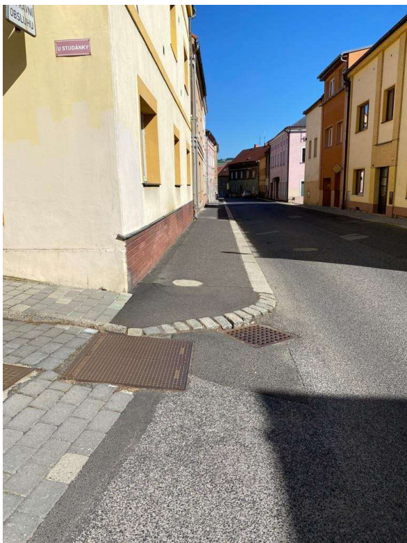
Oprava chodníku Palackého
